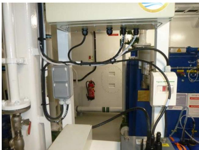
Prises électriques et interrupteur magnéto-thermique
