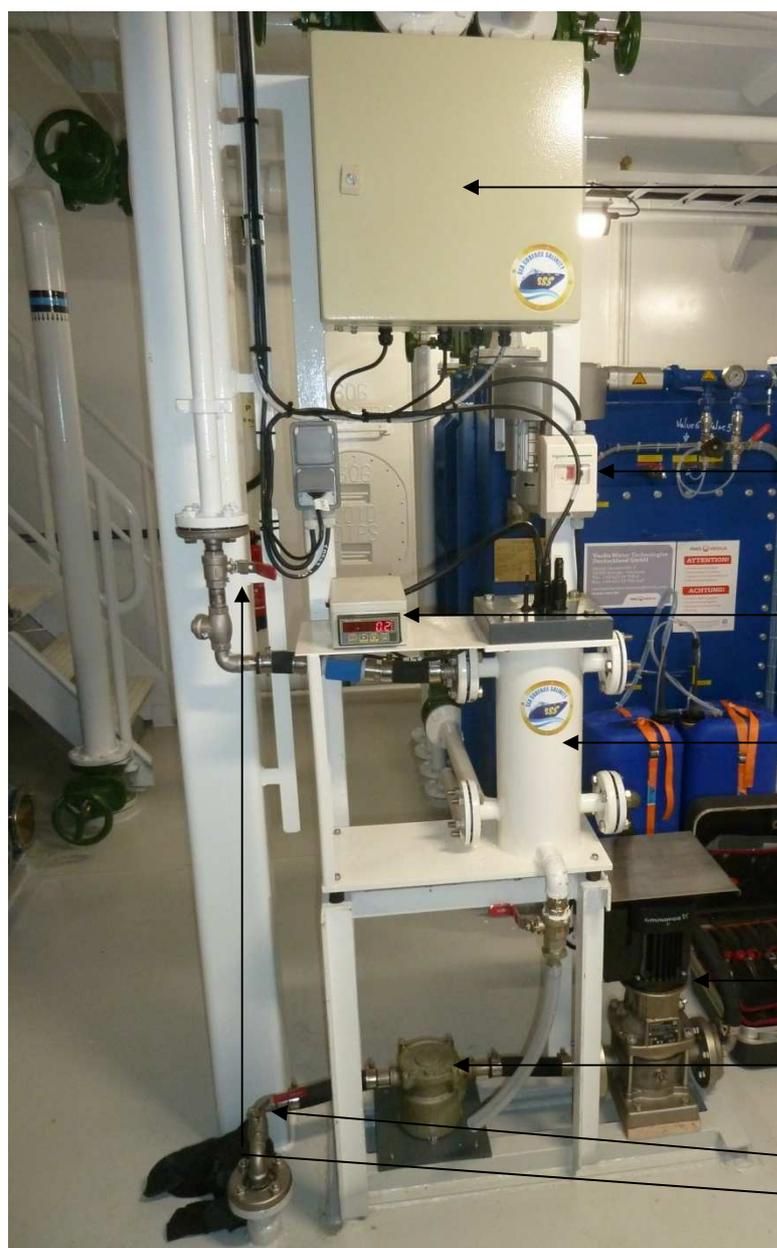
Coffret électrique : alimentation électrique et transfert des données
